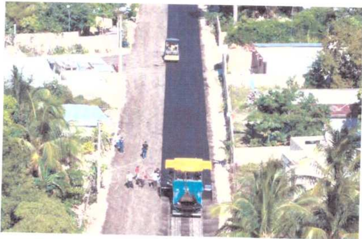
Rehabilitación de calles
