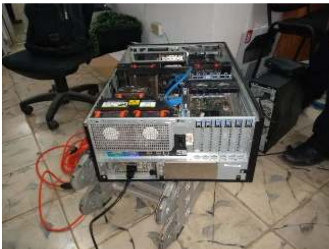
Cambio de fuente de poder de Servidor DELL POWEREDGE 1900 de Dirección de Catastro Municipal.
