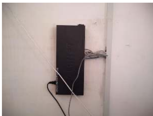
Instalación de red estructurada con switch para caseta de cobro de fin de año de Dirección de Ingresos Municipal.
